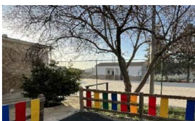
Imagen 10: Estado actual de algunas instalaciones a cubrir. / Fuente: Ayuntamiento Alcalá la Real.
