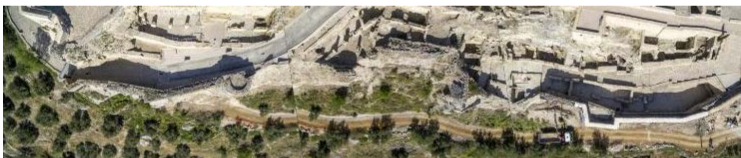
Imagen 20: Estado actual de la Muralla Oeste. / Fuente: Ayuntamiento Alcalá la Real.
